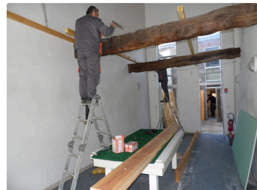
La pose d'un plancher/plafond réduira le volume et facilitera le chauffage
