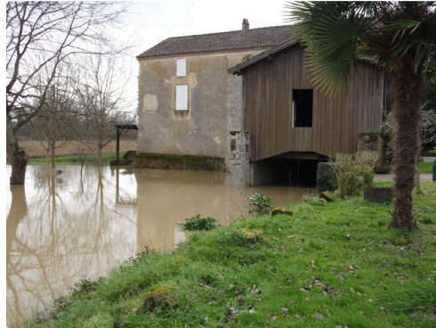
L'ancienne usine électrique devenue gîte rural revit son passé
