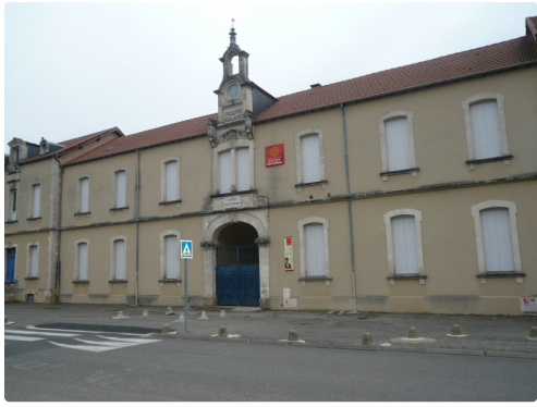
Initialement école des filles, les bâtiments qui abritent le lycée Alain-Fournier datent du début du siècle dernier.
