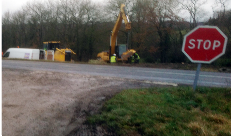
Sécurisation de la RN21
