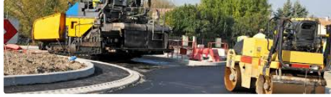
TRAVAUX SUR LA RN 124 DANS LA TRAVERSE DE VIC-FEZENSAC
