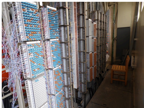
Le cœur du répartiteur les lignes des abonnés partent d'ici
