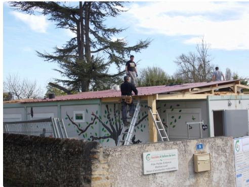
Avec ce toit l'eau ne s'infiltrera plus entre les cloisons
