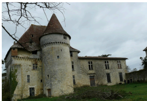
Face sud du château.
