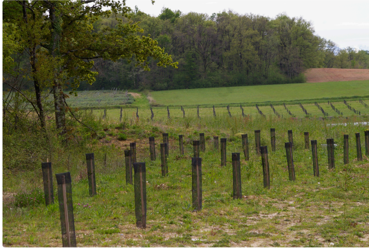
Retenue d'eau de "La Barne"
