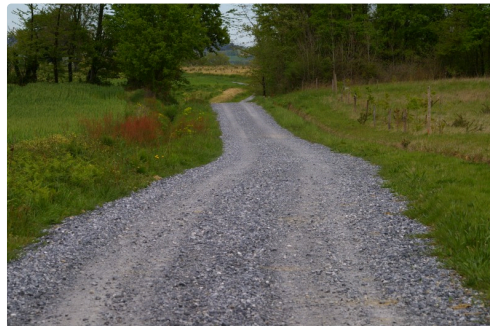
Le chemin de la crête voie d'accès a la retenue est refait
