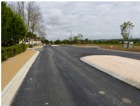
l'aménagement de la traversée du village
