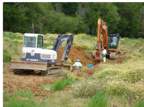
Une creuse la tranchée l'autre recouvre aussitôt
