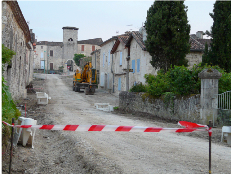
La Romieu: Les travaux de réfection de la rue DELOR ont commencé.
