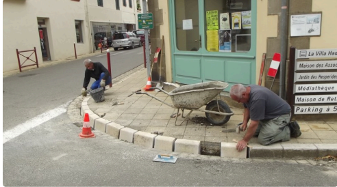
Les maçons municipaux réparent le trottoir
