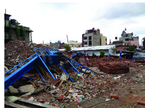
L'école Suryodaya après le séisme du 25 avril 2015.
