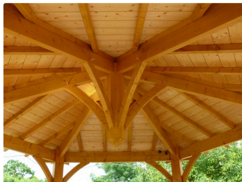
La charpente du kiosque, une oeuvre d'art réalisée par Rémi Caban.
