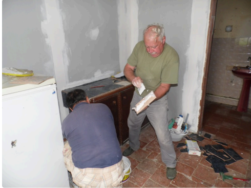
Carreleurs a l'ouvrage "Loulou"
