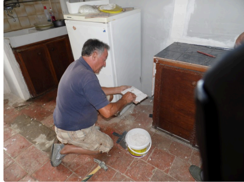
Carreleurs a l'ouvrage "Alphonse"
