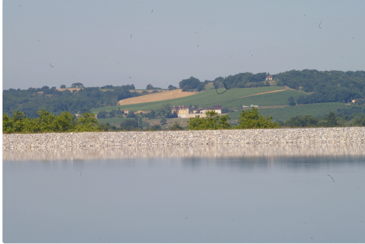
Le barrage de "La Barne" opérationnel
