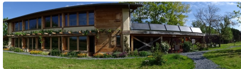
Le bâtiment de l'Eco-Centre Pierre et Terre Photo Marie Chavanne
