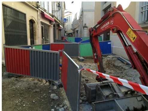
4 mois de travaux importants.
