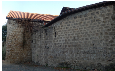
Murs d'enceinte et de protection
