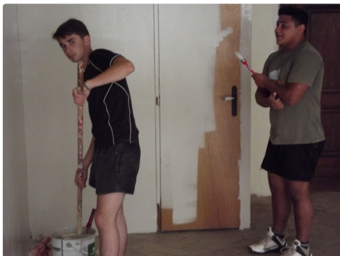
Travaux de peinture
