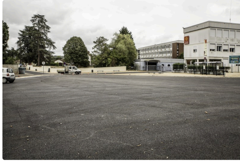
Devant la cité scolaire, le parking des cars
