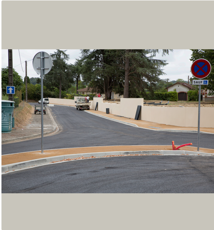
Nogaro – Les travaux devant la cité scolaire se terminent
