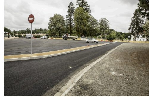
A gauche, la bordure du parking des cars et, à droite, la voie à sens unique (interdit dans ce sens)
