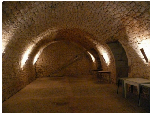
L'intérieur de sa salle des gardes restaurée.
