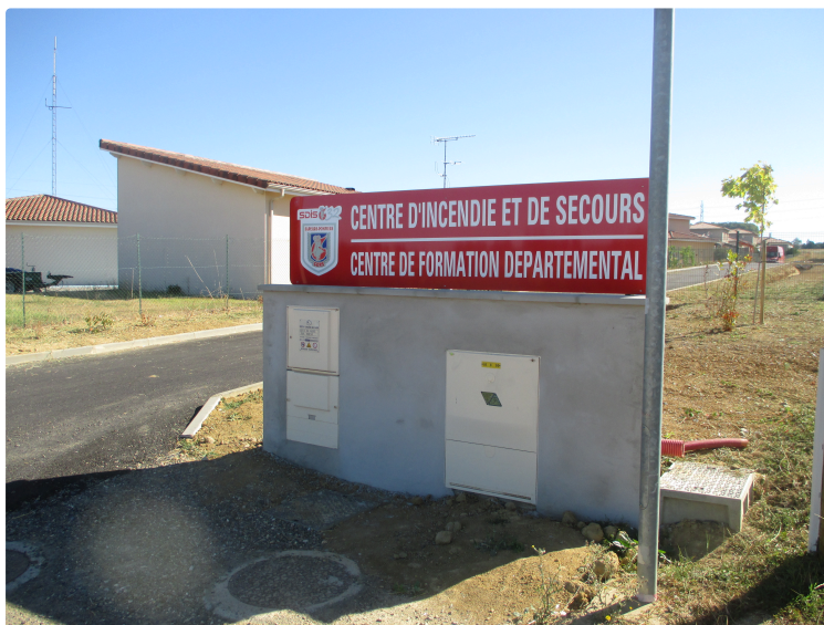
Le nouveau centre de secours
