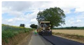
RN 124 : Travaux de réfection de chaussées sur la commune d'Ordan-Larroque du 12 septembre au 18 novembre
