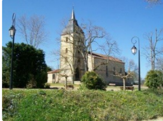
Journées du patrimoine à Ladeveze-Rivière
