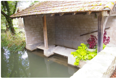
A classer au patrimoine également le dernier lavoir de Plaisance, avant l'arrivée de l'eau dans les maisons il y en avait presque une dizaine ( Photos Marcel Lavedan)
