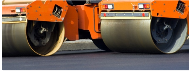
Commune de Lectoure : Travaux sur la RN21
