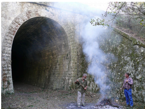
Un arrêté interdit toute circulation d'engins motorisés sur le viaduc et sous le tunnel.
