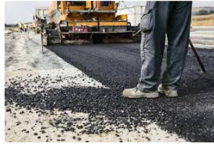
Travaux sur la RN 124, commune de Monferran-Saves du 12 au 19 octobre 2016
