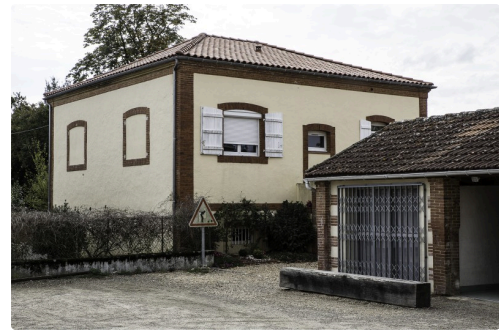
Coup d'œil sur l'ancienne école où a été aménagé un appartement locatif.
