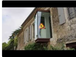
SAINT CLAR- Médiathèque
