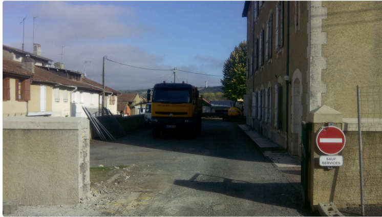
Maison de santé début des travaux
