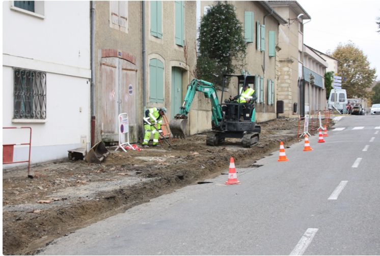
Travaux de voirie
