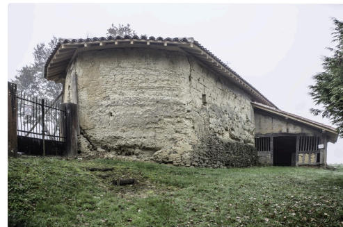
Vue de l'extérieur côté est
