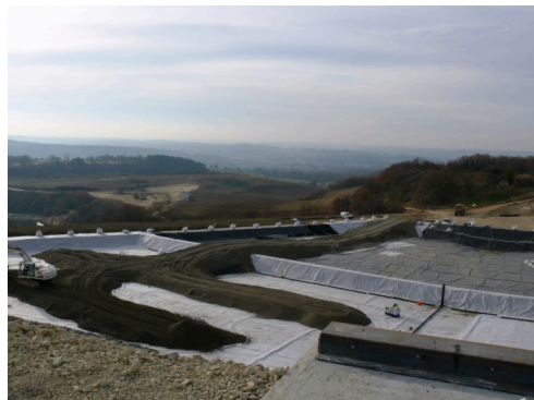
Vue d'ensemble de quelques casiers.
