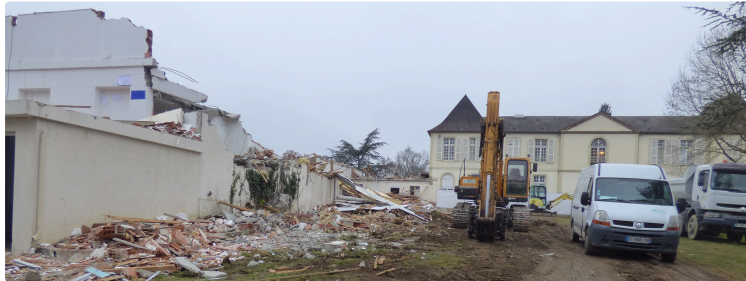
La rénovation du chateau d'Espagnet
