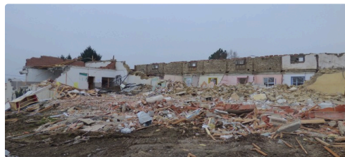
une vue d'ensemble du chantier de démolition
