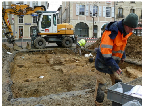
Vue globale du chantier.
