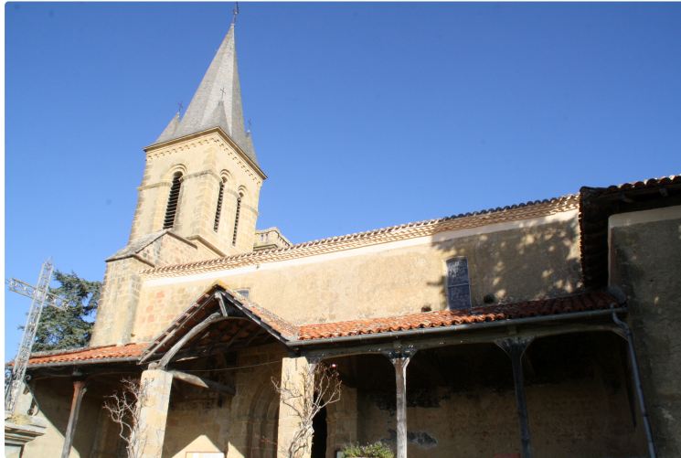
Sainte Dode : Rénovation de l'église
