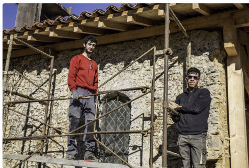
Décapage du mur extérieur
