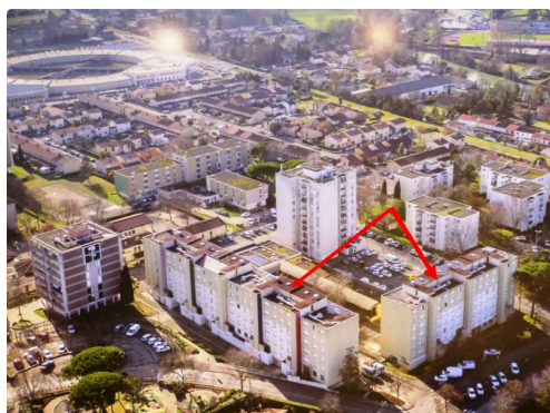
vue du Garros avec les deux bâtiments à détruire
