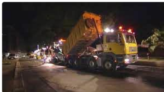
Travaux de réfection de chaussée sur la RN 524 sur la commune d'EAUZE du lundi 3 avril au mardi 25 avril 2017
