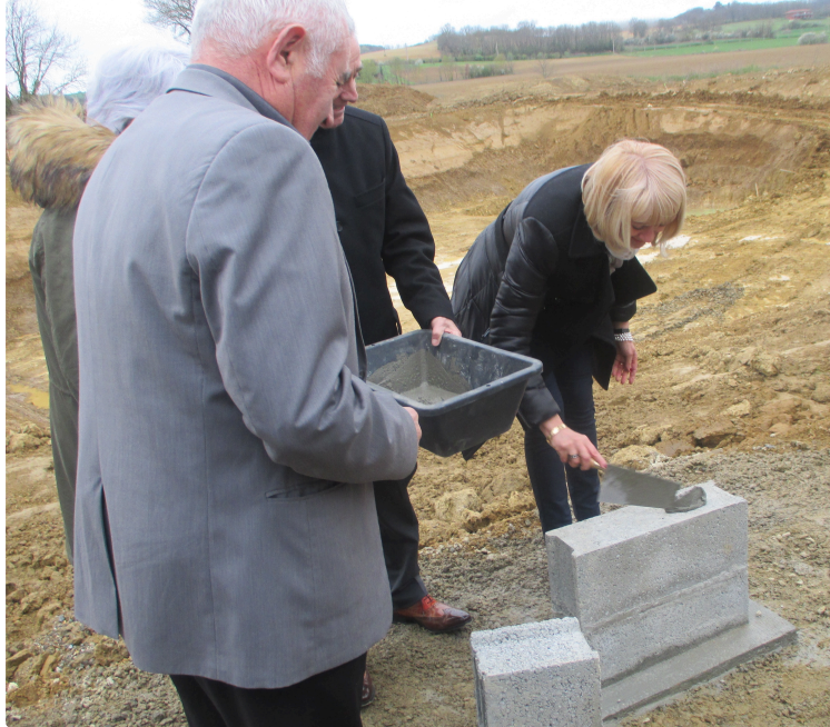
Vic-Fezensac - Pose de la première pierre de la station de pompage
