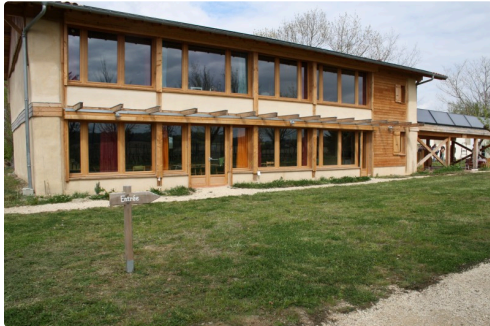
Un bâtiment exemplaire, démonstratif, performant... et économique Crédit photo archives Lionel Lemaire
