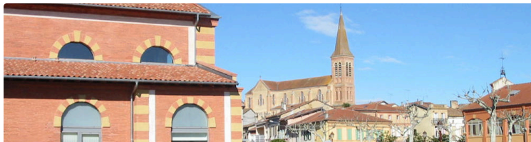
Samatan - Logements locatifs indignes occupés
