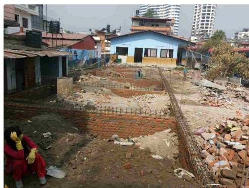
le chantier se poursuit à la SAB Public School
