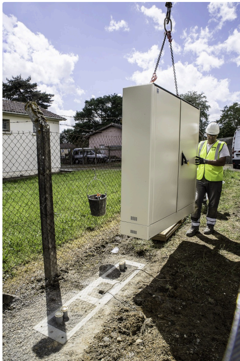
5 L'armoire arrive sur son emplacement définitif que l'on voit au 1er plan
