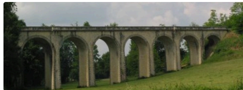
Viaduc de Castin.
