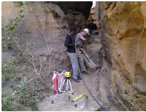
Captage dans la falaise
