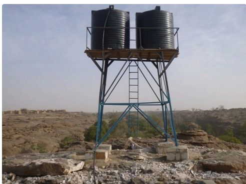
Mise en place d'une citerne
