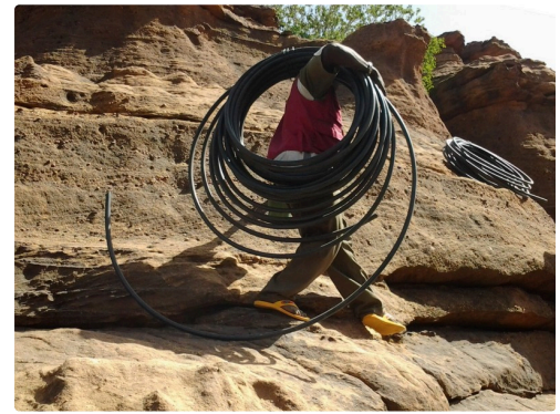
Pose de la conduite
