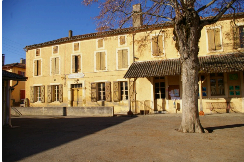
La bâtiment originel il y aura deux niveaux desservis par ascenseur
