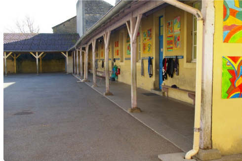
Bâtiment à niveau unique la coursive disparaîtra
